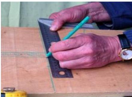
1. Utiliza las dimensiones en milímetros dadas en el plan anterior para dibujar las líneas de corte en tu placa de madera de 22 mm de grosor.
